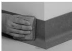
przecierając je w miarę przykładania do powierzchni.
