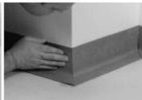
Zamontować listwy HSLA. Listwy należy dociskać solidnie.
