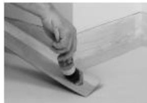
Nanieś klej na podłogę i ścianę między tymi liniami.
