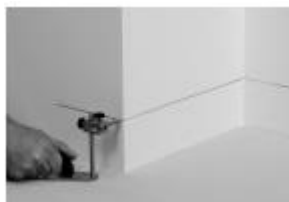
Nanieś linię, do której wykładzina ma być wyłożona na ścianę.
