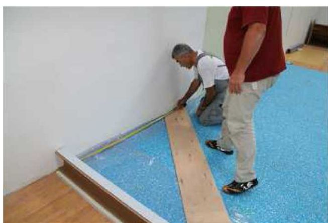
Instalacja pierwszego panela Tarflex
